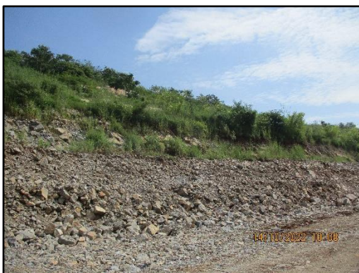
ภาพที่ 2.7 การนำเศษหินและเศษดินทำคันดินสำหรับปลูกต้นไม้บริเวณพื้นที่ที่ผ่านการทำเหมือง
