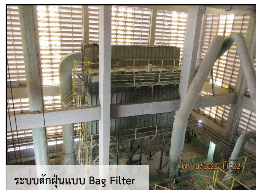
ภาพที่ 2.8 อาคารบดย่อยหินเป็นแบบปิดและติดตั้งระบบดักฝุ่นชนิด Bag Filter และม่านป้องกันฝุ่นฟุ้งกระจายเพื่อป้องกันฝุ่นออกสู่ภายนอก
