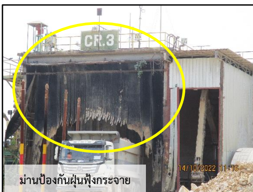
ภาพที่ 2.8 อาคารบดย่อยหินเป็นแบบปิดและติดตั้งระบบดักฝุ่นชนิด Bag Filter และม่านป้องกันฝุ่นฟุ้งกระจายเพื่อป้องกันฝุ่นออกสู่ภายนอก
