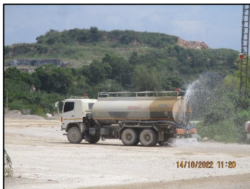
ภาพที่ 2.13 รถบรรทุกฉีดพรมน้ำบนเส้นทางลำเลียง
